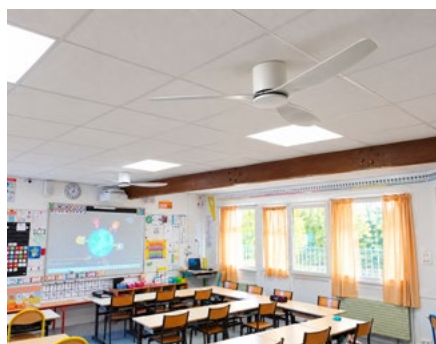
Brasseurs d'air à l'école élémentaire du Corail
