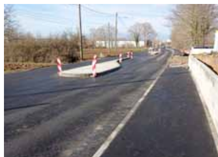
11 Route de Cayras (section Champs Pinsons / Caoussé) : sécurisation lieu de la portion de la RD54, du Caoussé au rond-point de Catala, par la création d'un tourne-à-gauche, d'un trottoir et réfection de la chaussée.
