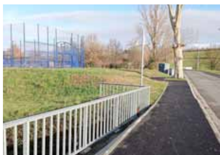
1 Avenue de la Marqueille / route de la Jurge : création d'un trottoir depuis l'arrêt de bus des « Carabènes » jusqu'au Skate Park.
