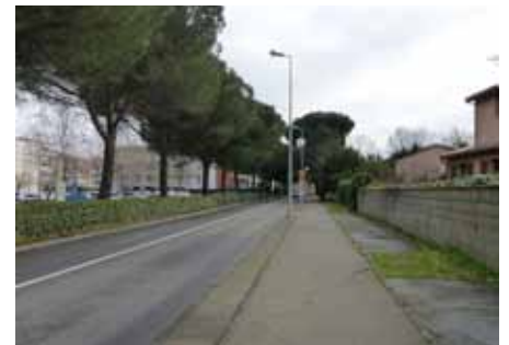
13 Route de Revel (section allée des Pins/Tardieu) : réfection en cours de la piste cyclable.
