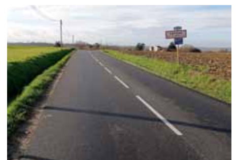
15 Route RN57 : recalibrage de la chaussée de Cayras à Quint.
