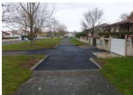
6 Avenue du Mail : réfection des accès et abaissement des bordures pour améliorer les conditions de circulation des piétons.
