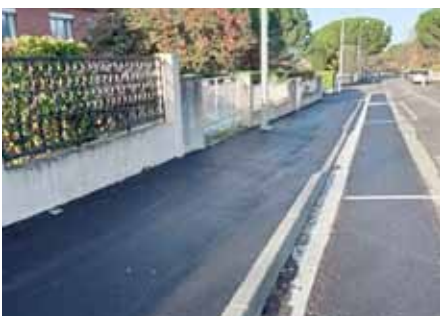
7 Rue de Lentourville (section Jean Bellières / rue du Bousquet) : réfection des trottoirs et création d'un passage piéton au niveau du n°4 de la voie.
