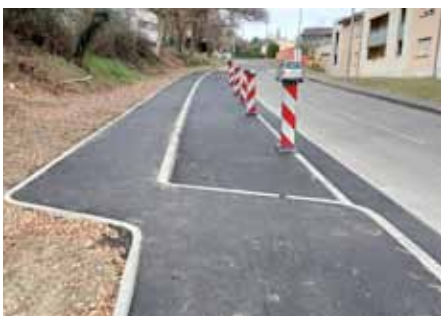
9 Rue des Sports : création lieu d'un trottoir, d'un passage piéton et de places de stationnement entre la rue Olympe de Gouges et la rue Marie Curie.
