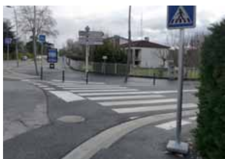
3 Avenue Louis Couder : sécurisation du passage piéton proche du giratoire de la gendarmerie.
