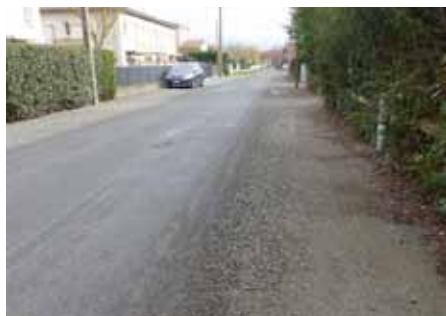
2 Rue des Vignes : empiérement des accotements enherbés et pose d'un enduit superficiel sur la chaussée.
