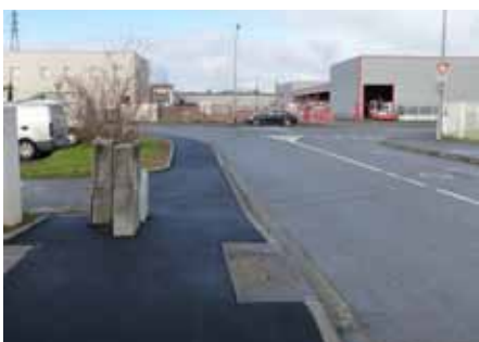
10 Boulevard du Libre Echange et rue du Négoce : sécurisation et mise en accessibilité de l'espace public en créant des trottoirs, des traversées piétonnes et deux mini-giratoires.
