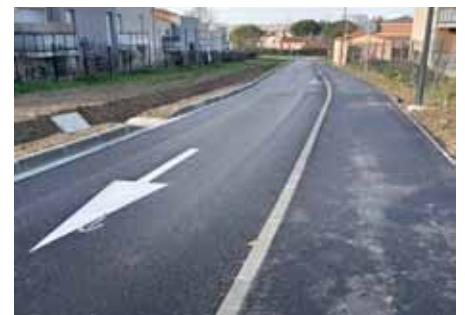
14 Rue de la Pradelle : réfection de la chaussée et des trottoirs.
