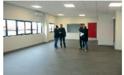
Réception des travaux, salle de Tarot et de Bridge
