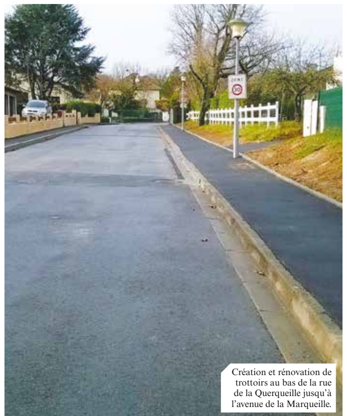
Quartier Catala. Le parvis de l'église a été entièrement rénové (photo). Rue de Beauséjour, 5 places de stationnement vont remplacer le terre-plein central suite à la réfection des réseaux d'assainissement.
