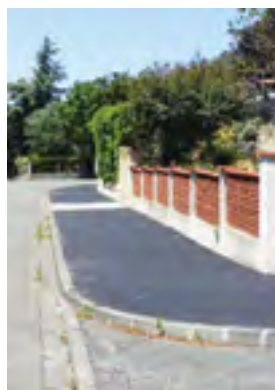
Travaux de réfection de la voirie la rue de Couli, avant et après intervention.
