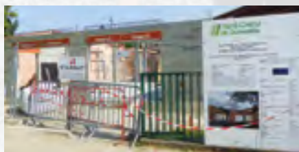
Les travaux d'extension de l'école maternelle Henri Puis.
